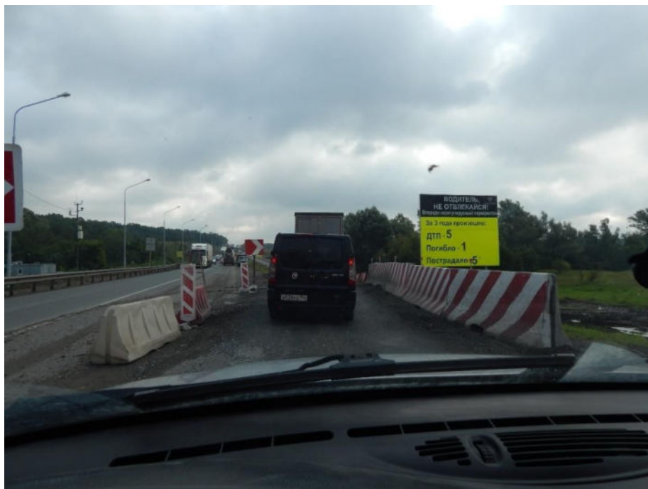
Фото 06. Ремонт через р.Тауш
